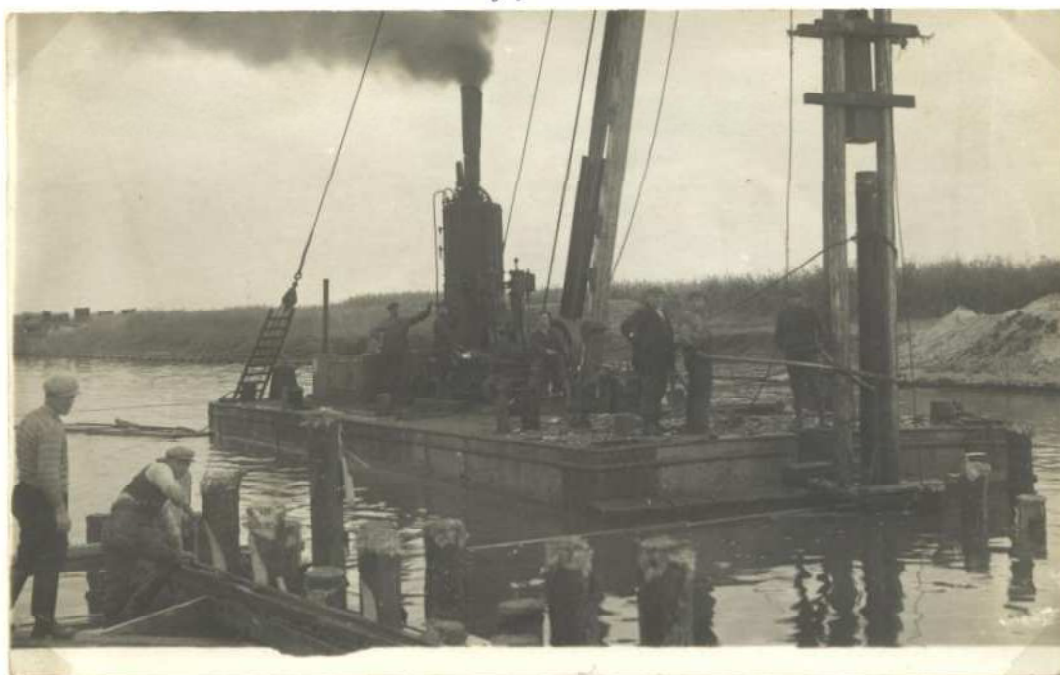
Gerard Ooijevaar (5{8{10(2^05+ 0/1) werkzaam bij het aanleggen van een brug in de Wieringermeer
